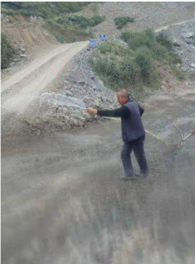
场地洒水除尘
