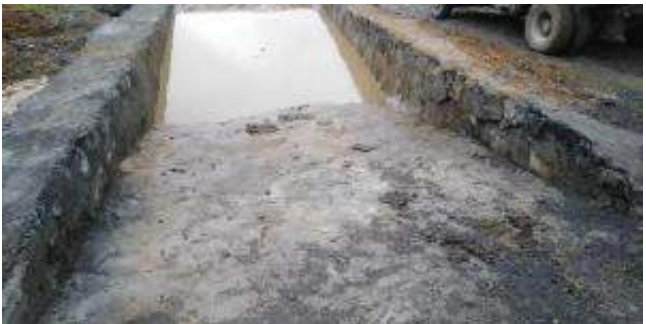
进出厂区轮胎清洗池
