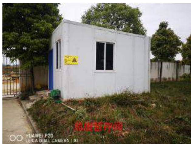
附图 2、危废暂存间
